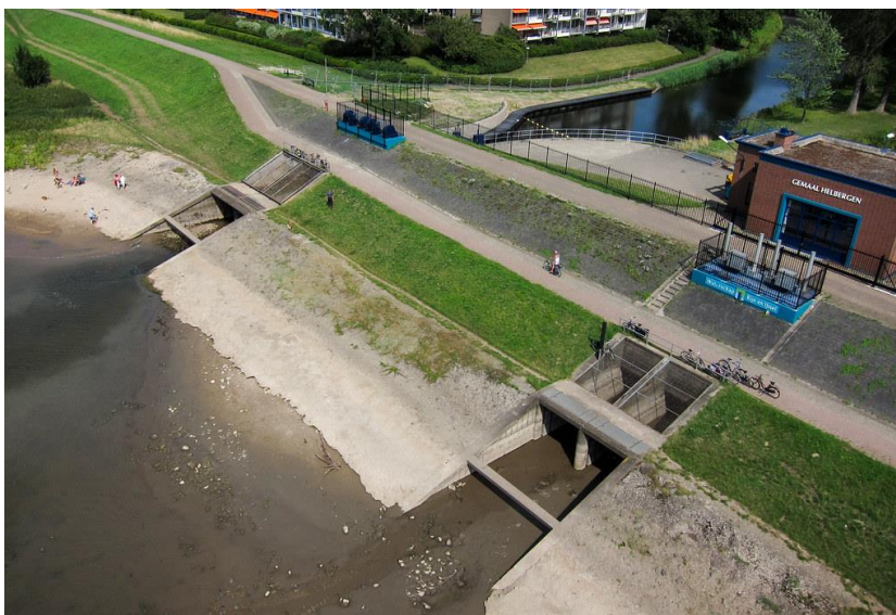
Afbeelding 2.1 Gemaal Helbergen en spuisluis
